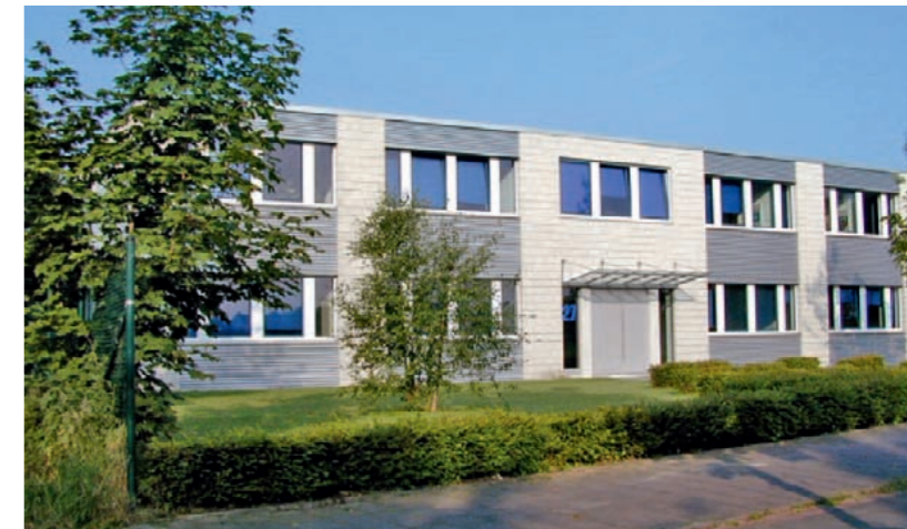
1993 zog die damalige LIS Wagner & Partner AG ins unternehmenseigene Gebäude am Hansaring in Grevener. Mit dem Neubau stehen der LIS bald die doppelte Bürokapazität sowie eine Tiefgarage zur Verfügung. Anfang 2011 sollen die Bauarbeiten abgeschlossen werden.
